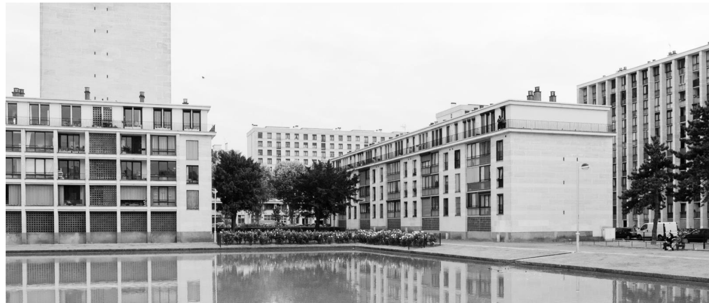
La Résidence du Parc Meudon-la-Forêt Fernand Pouillon architecte 1960-61.
