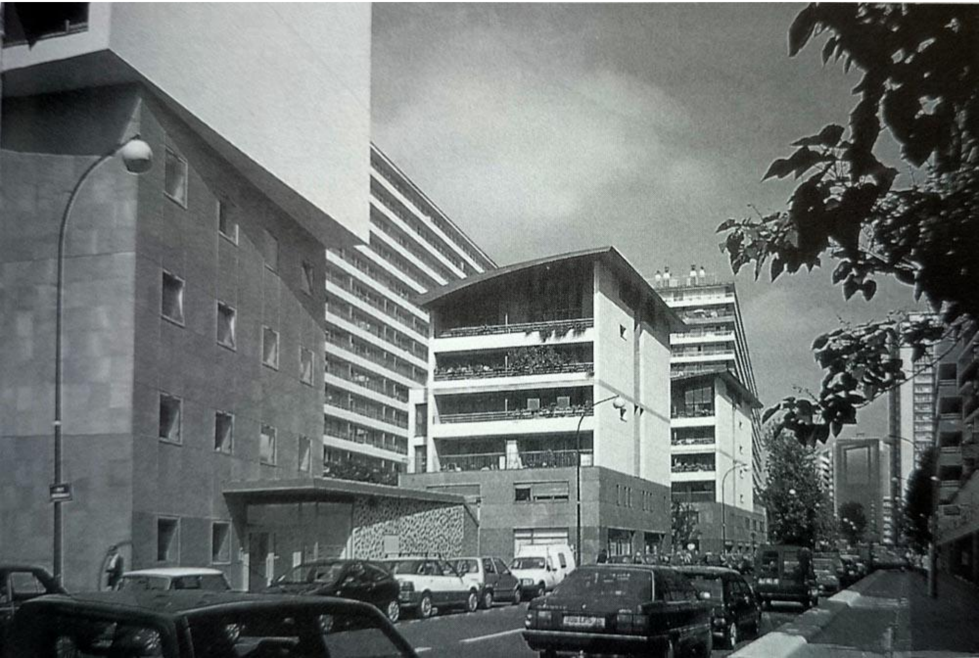
Christian de Portzamparc Rue Nationale, Paris 19 e Réhabilitation de logements
