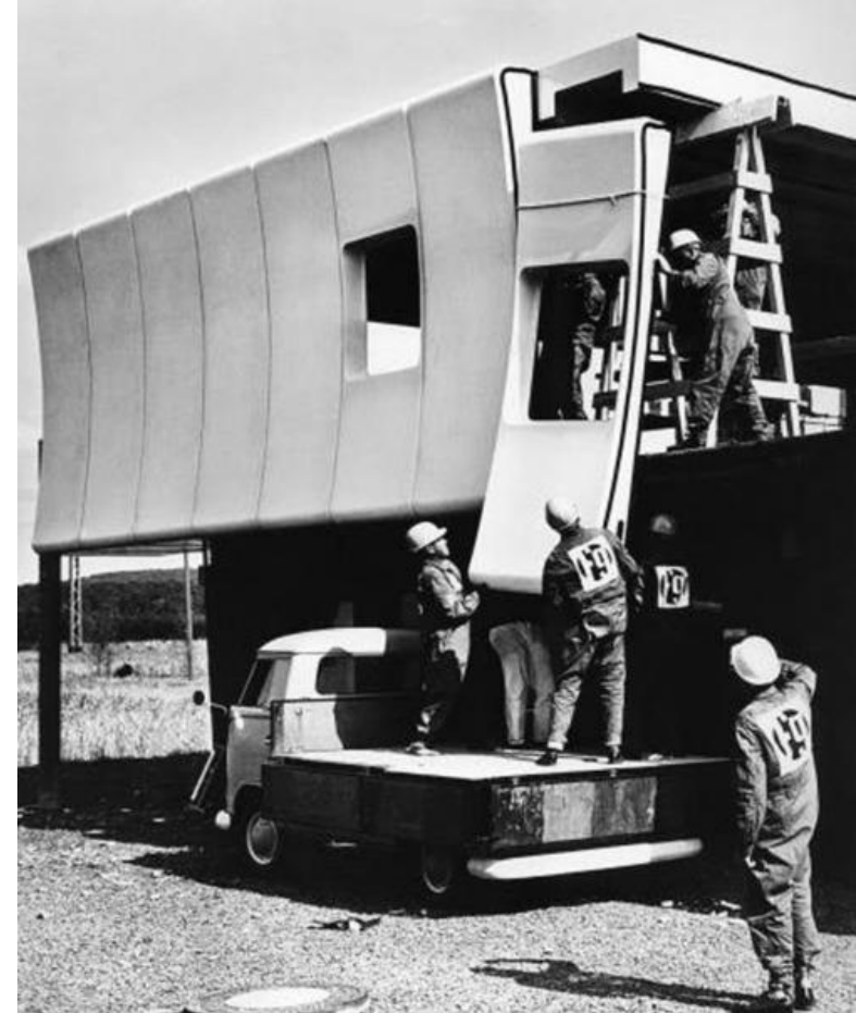
Assemblage de panneaux préfabriqués
