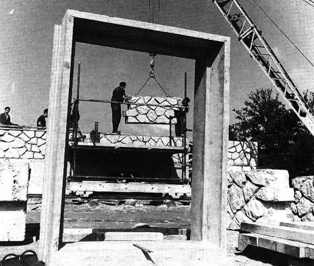
Mur de moellons préfabriqué
